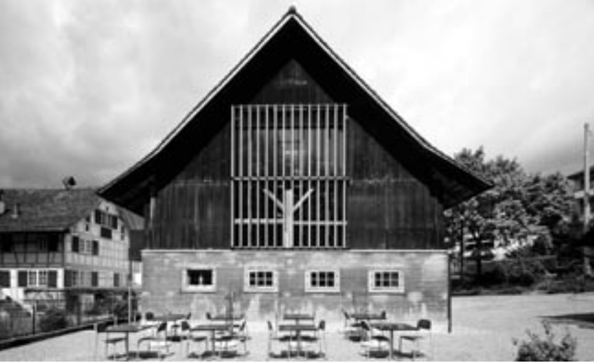
Quartiertreff Hirslanden: Saal und Cafeteria in der alten Scheune (Foto: H. Henz)
